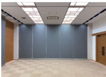
間仕切りを設置した状態
